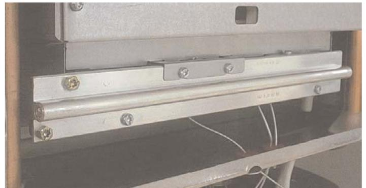
**El encendido** del quemador se efectúa mediante un tren de chispas entre los **dos electrodos (1 & 2)** por encima de las boquillas de gas. El tren de chispas está asegurado por un encendedor electrónico (A) situado directamente sobre la carta electrónica.
